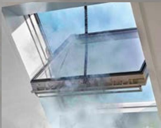
Mit dem Auslöser im Eingangsbereich wird die Entrauchungsklappe geöffnet und der Rauch ins Freie befördert.
