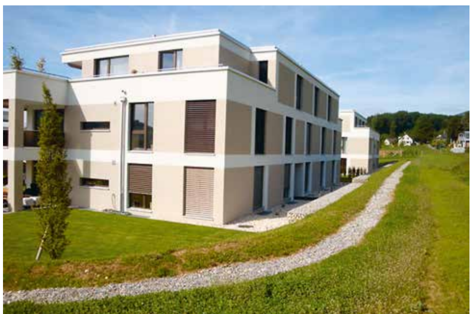
Die SGV unterstützte die Siedlung Wendelin beim Bau des Erdwalls mit Drainage.
