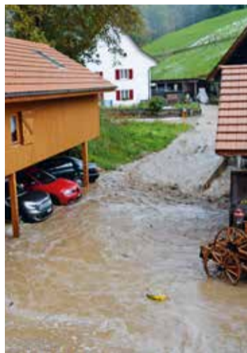
Grosse Schäden an Gebäuden, wenn Wasser nicht mehr abfliessen kann
